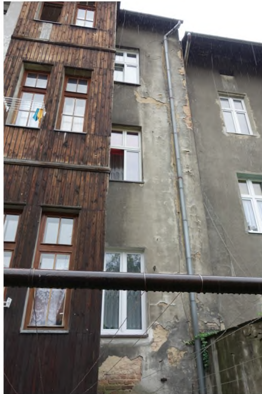
Istniejące przewody odprowadzające na elewacji tylnej
