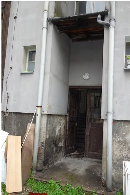
Istniejące przewody odprowadzające na elewacji tylnej
